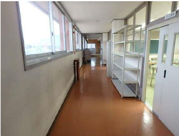
附属京都小中学校廊下改修
